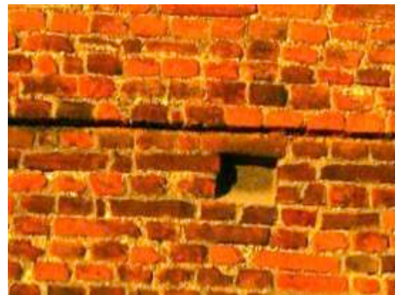
Fig.18: S. Maria alla Fontana – MI, muratura delle buche pontaaie
