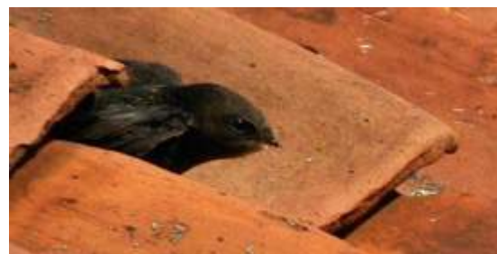
Fig.58: accesso al nido da una fila di coppi interna
