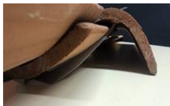
Fig.108: dettagli dell'ancoraggio dei coppi
