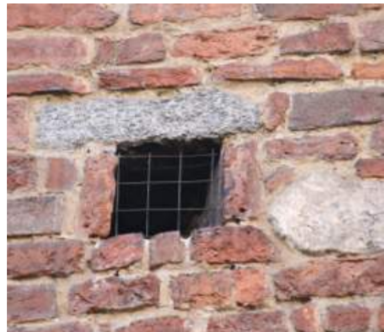
Fig.62: S. Sepolcro - MI, buche puntaie chiuse con rete metallica
