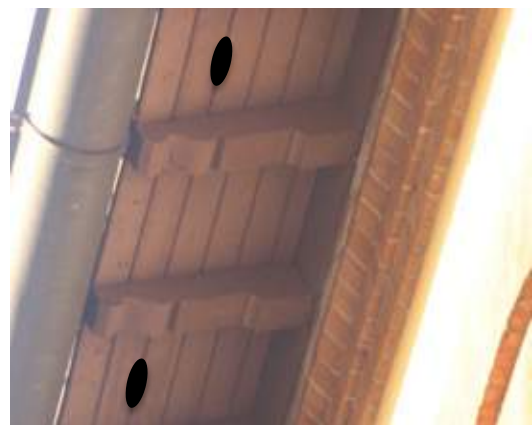
Fig.118: foratura dello sporto di gronda
