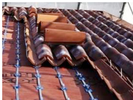
Fig.107: procedure per il fissaggio laterale dei coppi mediante ganci in alluminio
