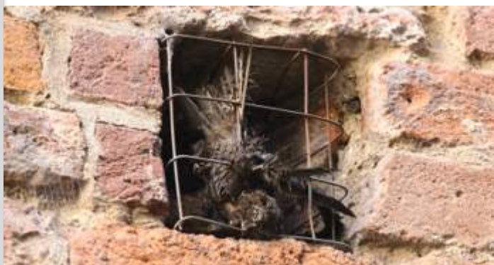
Fig.63: San Satiro - MI, buche pontai chiuse con rete metallica a maglia 5 x 5 cm
