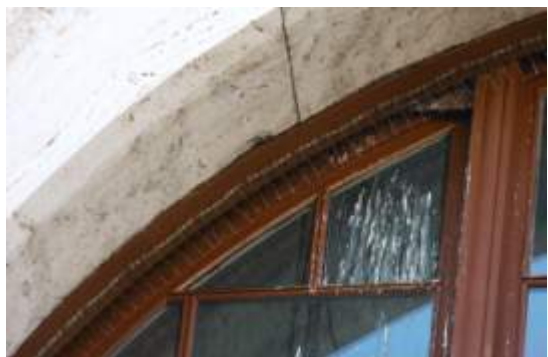
Fig.72: Palazzo della Borsa, aghi anti piccione
