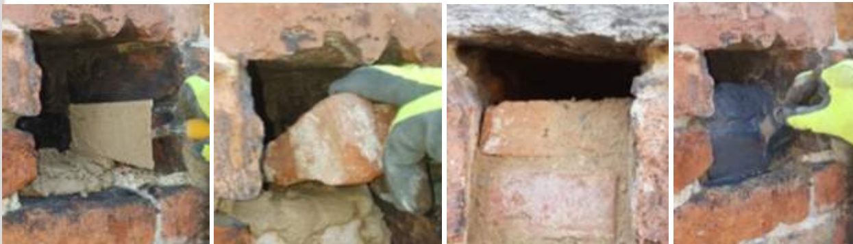
Fig.89: sequenza delle operazioni di riduzione selettiva delle buche puntaie
