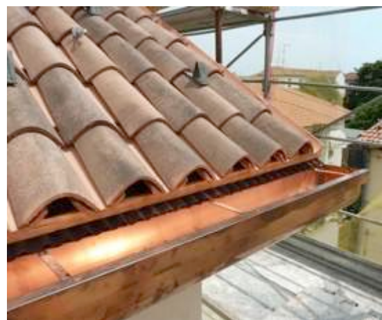
Fig.109: fissaggio dei coppi con dentello trattenuti da una listellatura lignea
