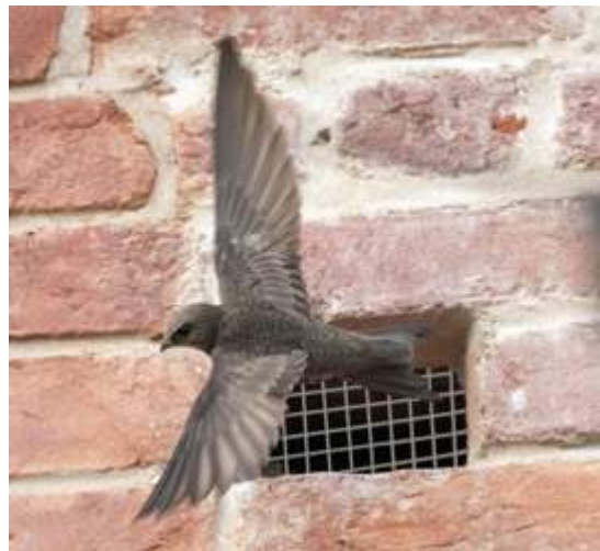
Fig.91: buca pontaiia chiusa con rete metallica
