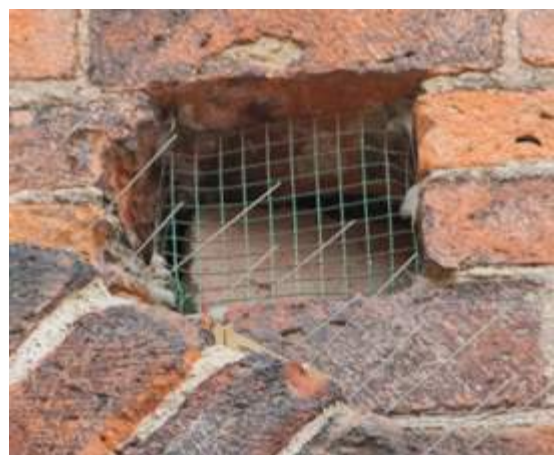
Fig.85: bucha pontaaia: dispositivi anti piccione
