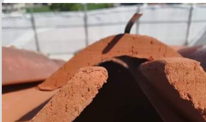
Fig.107: procedure per il fissaggio laterale dei coppi mediante ganci in alluminio
