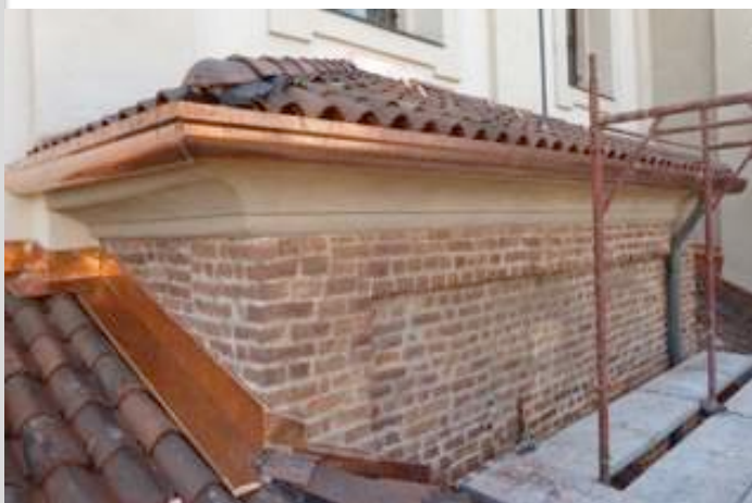
Fig.109: fissaggio dei coppi con dentello trattenuti da una listellatura lignea
