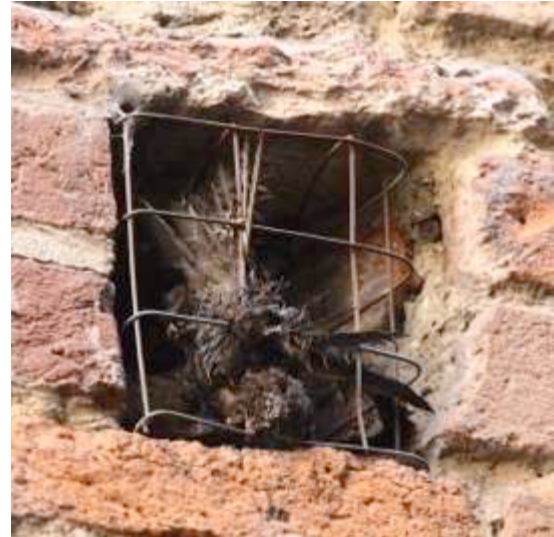
Fig.17: San Satiro - MI, chiusura buche pontaaie con rete metallica
