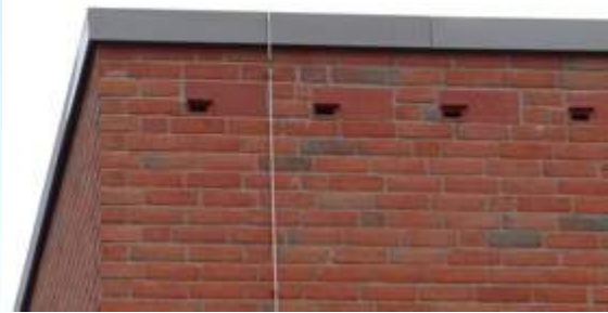
Fig.120: Milano (sn) palazzo ristrutturato con cassette nido fissate alla facciata; SOS Rondoni. (dx e in alto) Francoforte: esempi di cassette nido inglobate nelle facciate dei palazzi
