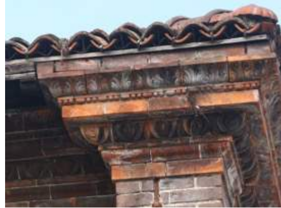
Fig.56: Castello Sforzesco - MI, coppi senza gronda
