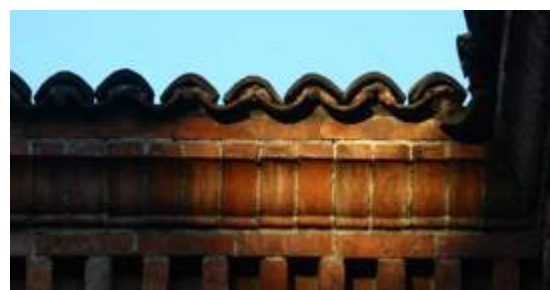
Fig.66: Università Statale Festa del Perdono – MI. Coppi chiusi con malta
