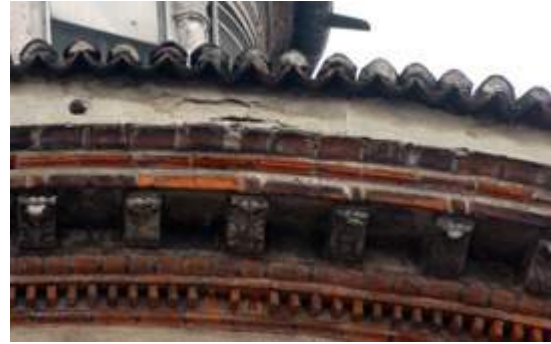
Fig.67: San Vittore al Corpo – MI. Coppi chiusi con malta
