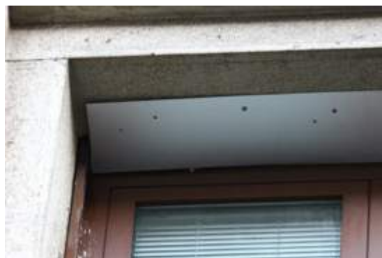
Fig.71: Stazione Centrale, chiusura degli accessi ai nidi
