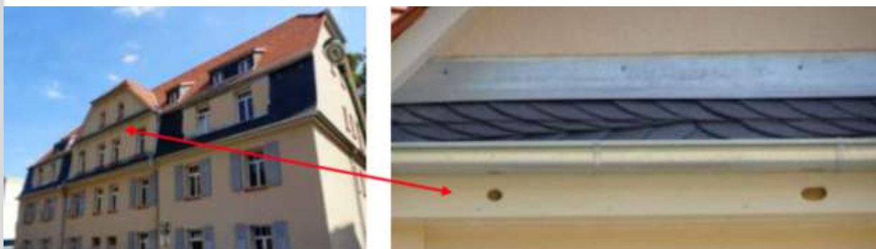
Fig.38: Francoforte – cassette nido interne alla facciata
