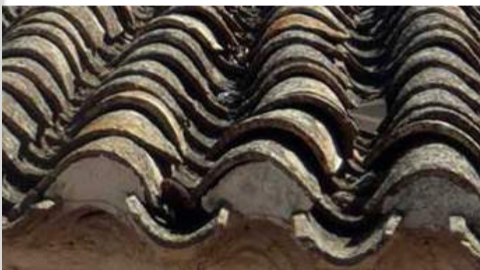
Fig.19: S. Vittore al Corpo – MI, coppi chiusi con malta
